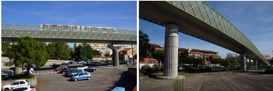
FIGURE 3.2 – Un métro arrivant en gare de Jolimont (gauche), entre les piles centrale et basse du parking haut; le viaduc plongeant sous terre dans le prolongement du parking bas (droite). Crédit Nicolas Janberg ( structurae.net/fr/ouvrages/ligne-a-du-metro-de-toulouse ).
