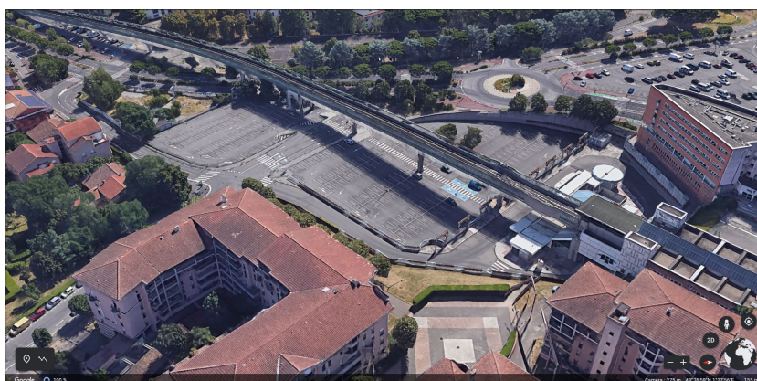
FIGURE 3.1 – La station de métro Jolimont à Toulouse (à droite) prolongée par un viaduc ferroviaire vers le nord-est. Crédit Google Earth ( earth.google.com/web ).
